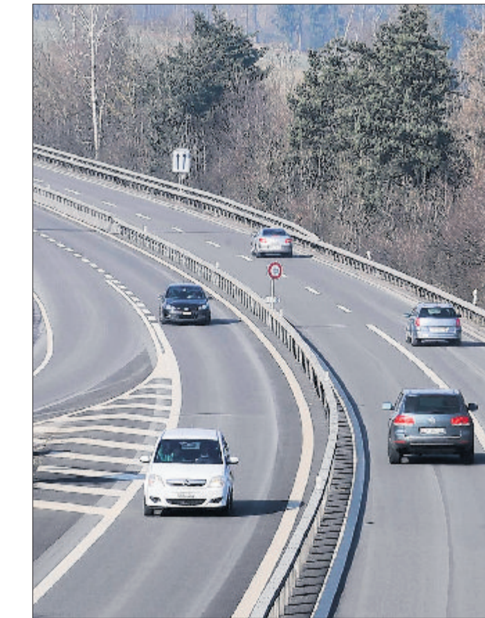
Die Forchautostrasse ist dank der neuen Mittelleitplanke nicht mehr die unfallträchtigste im Kanton Zürich. (Reto Schneider)
